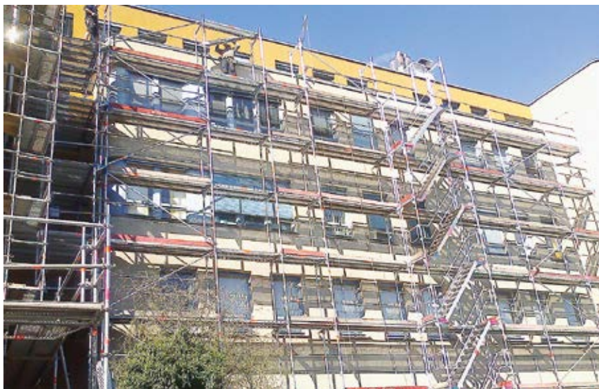
Arbeiten an der Hoffassade des Ärztehauses
