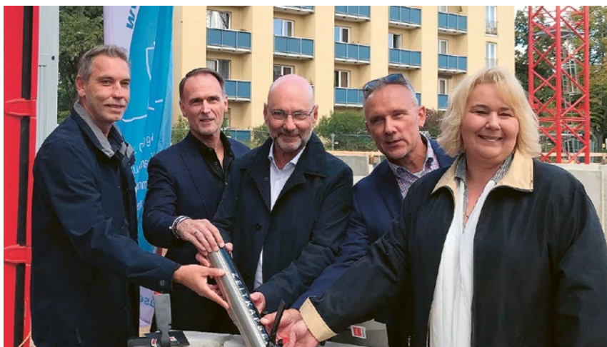
V.l.n.r.: Dirk Bork (Aufsichtsrat), Roman Lichtl (Architekt), Michael Abraham (IDEAL-Vorstand), Ralf Strohe (Baufirma Köster) und Kathleen Beständig (IDEAL-Vorstand).
