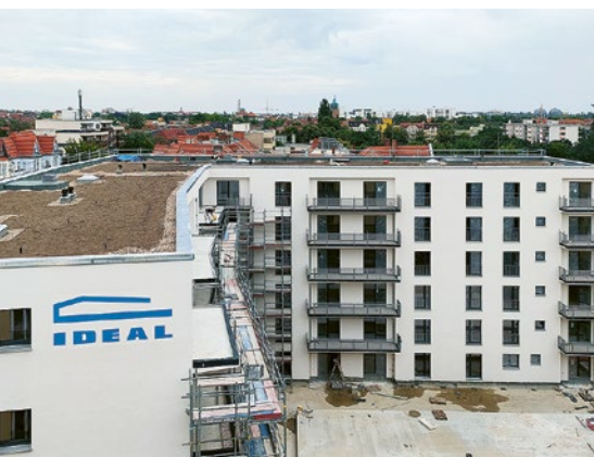
Im Juli: Der Neubau ist teilweise abgerüstet.
