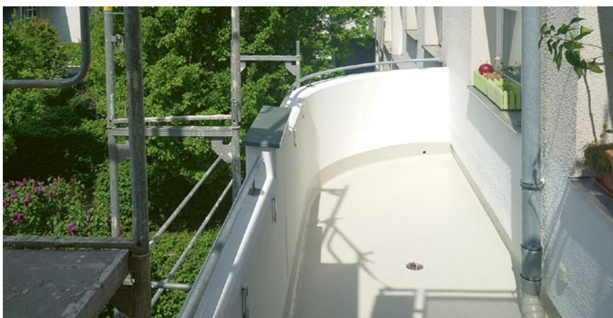
Erneuerter Fußbodenaufbau an den Balkonen in der Rungiusstraße
