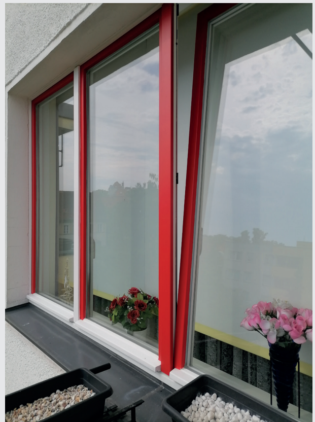
■ Erneuerung Fensteranstrich in Britz
