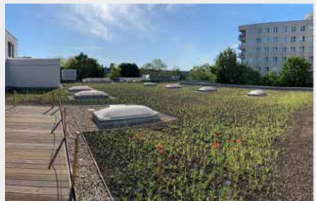
■ Gründach Britzer Damm
