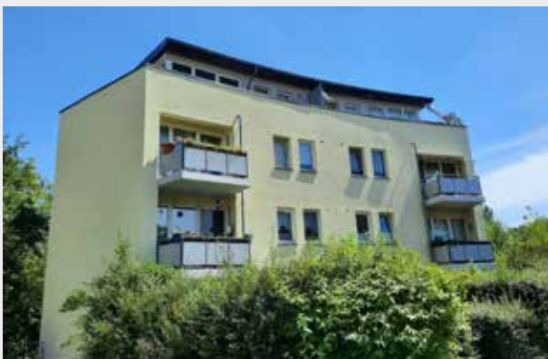
■ Erneuerung Fassade Fleischerstraße
