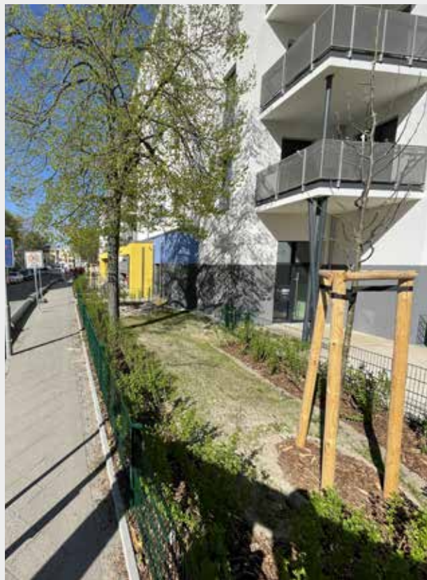
■ Außenanlage Neubau Rathaus- / Ullsteinstraße
