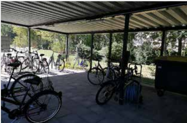
■ Beleuchtung Fahrradkäfing Buckow
